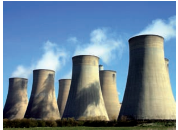
Aufwändige Kühlung bei zu viel Abwärme
